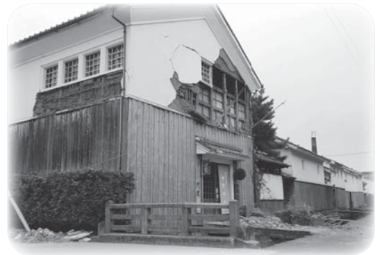
被災した倉吉白壁土蔵群（写真提供：倉吉市）
