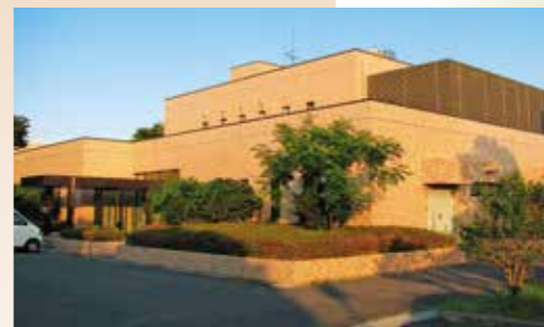
下水道 センター
