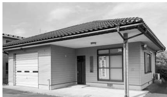
JR 余子駅前にある本市消防団第二分団の 拠点となっている建物
