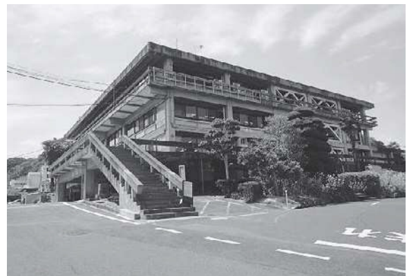
倉吉市庁舎では1998年（平成10年）にエレベーターを追加設置 （提供 倉吉市役所）
