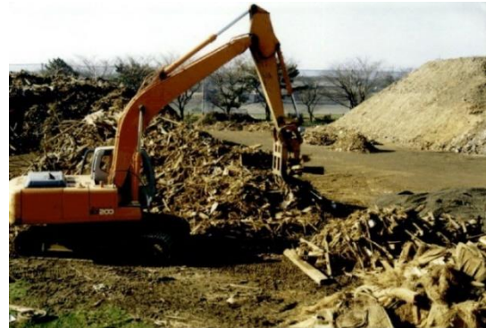
写真:鳥取県西部地震(平成12年)時の境港市内での復旧作業の様子
