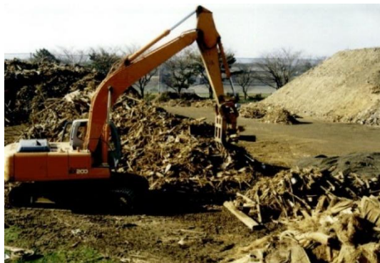
写真:鳥取県西部地震(平成12年)時の境港市内での復旧作業の様子
