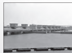
【参考】 完成当時の中浦水門
