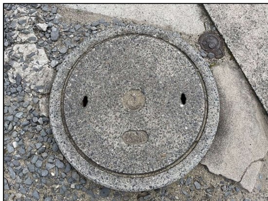
①：コンクリート製公共汚水柵
