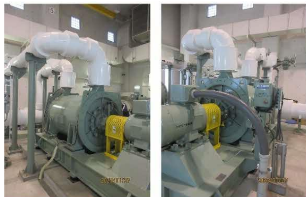
写真 3-3 下水道センターでの高効率のブロワ電動機 (1 台) への更新
