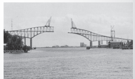
完成間近の境水道大橋 (鳥取県公文書館所蔵)
