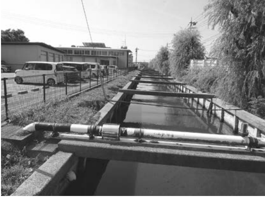
下ノ川最下流部の状況
