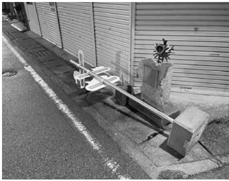
水木しげるロードと境港水産物地方卸売市場の相互誘客をはかる強風で倒れた案内看板
