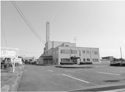
焼却炉部分が取り壊される 境港市清掃センター
