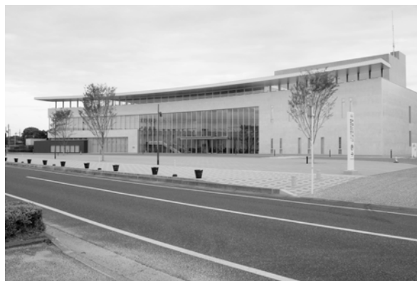
みなとテラス正面アプローチに設置された 注意喚起プランターとポール
