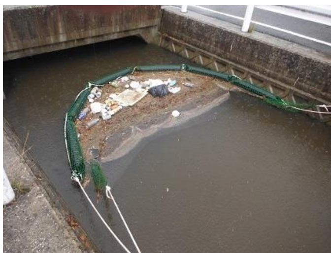
《ネットフェンスによるごみ回収／下ノ川》
