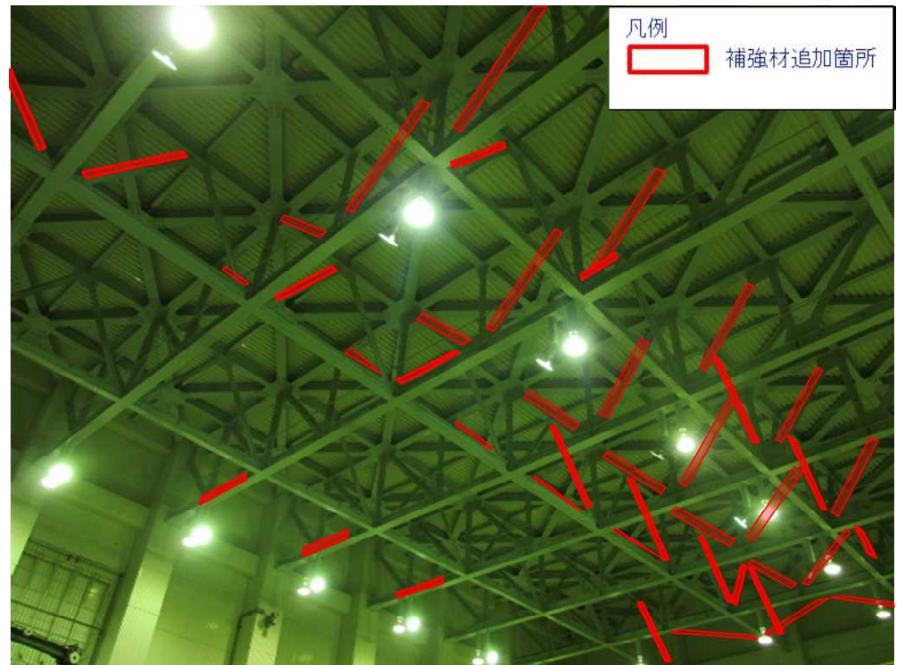
原子炉建物耐震補強工事状況
