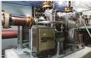
高圧原子炉代替注水ポンプ
