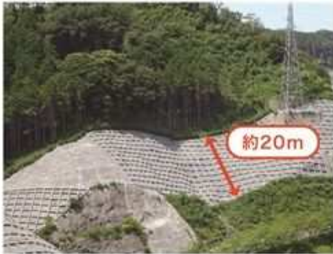
発電所への森林火災の延焼を防ぐ防火帯
