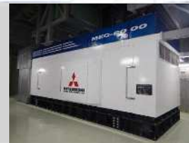
ガスタービン発電機
