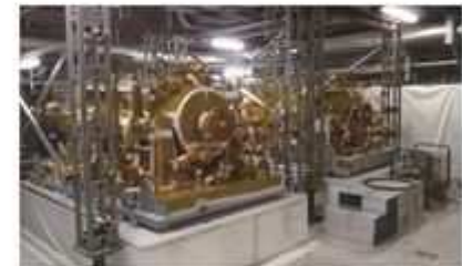
残留熱代替除去ポンプ
