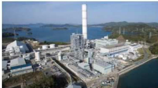
実証試験設備の様子
