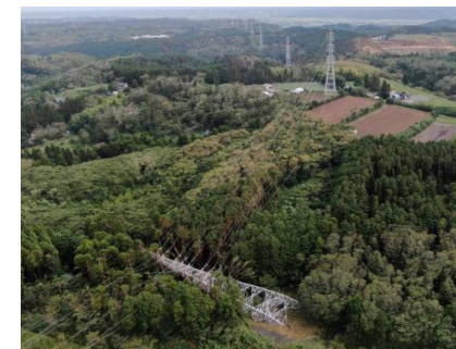
鉄塔設備の倒壊 (君津市)
