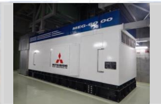
ガスタービン発電機
