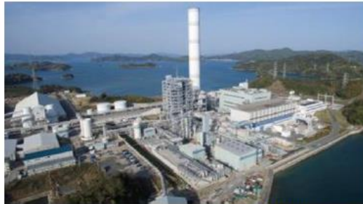
実証試験設備の様子
