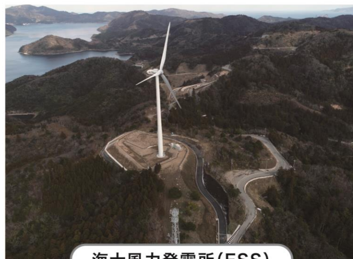
海士風力発電所(ESS)
