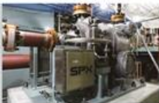
高圧原子炉代替注水ポンプ
