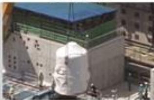
フィルタ付ベント設備
