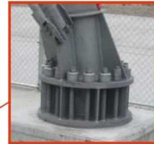
「緊急時の情報通信ネットワーク」のための耐震性の高い通信設備
