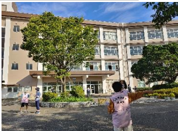
三中は改修工事が終わってきれいな校舎になりました。生徒のあいさつ運動も始まっています。
