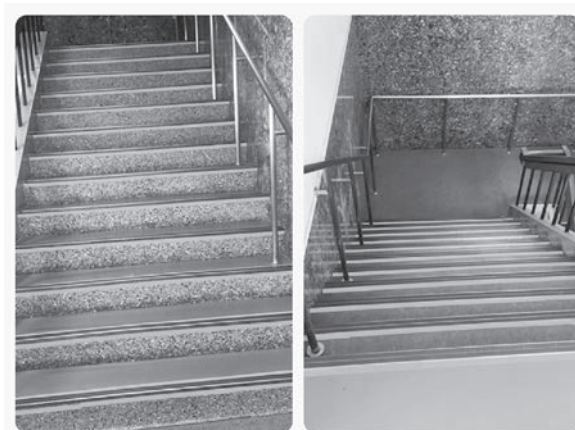
ロービジョン当事者の声が反映され、 オレンジテープが貼られて 段差がわかりやすくなった本庁舎の階段
