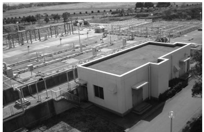
ストックマネジメント計画の進む 下水道センター
