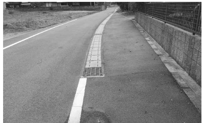
改修された狭あい道路 (三軒屋町内)
