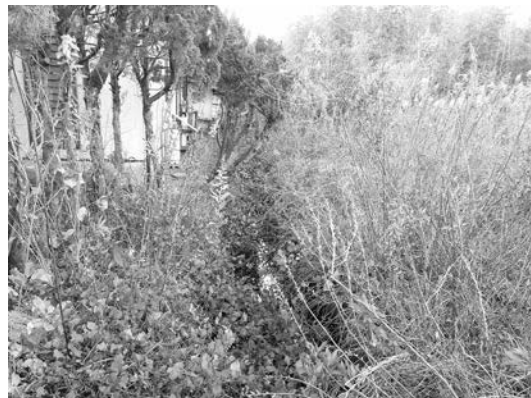
市内にある既存排水路の現況の一部
