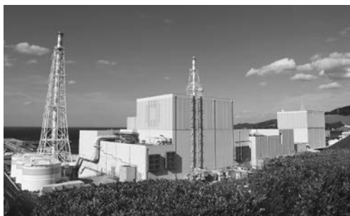
島根原子力発電所 (中国電力(株)提供)
