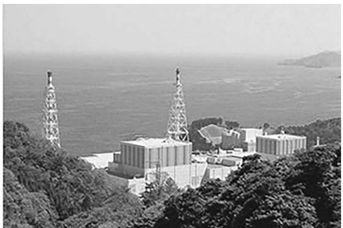
島根原子力発電所 (中国電力(株)提供)
