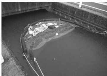
試験的に設置された ネットフェンス (市内河川)
