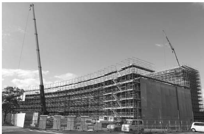
新しい指定管理者が決まった建設中の市民交流センター
