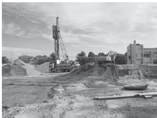
4期在任中の最大事業となる (仮称) 市民交流センター工事風景
