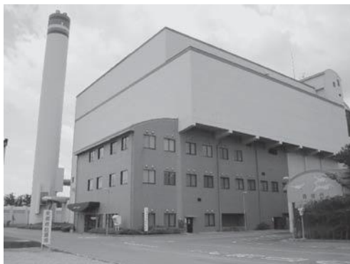
境港市の可燃ごみ処理を委託している 米子市クリーンセンター (写真提供：米子市HPより)
