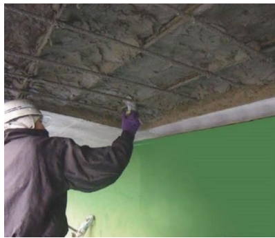
『亜硝酸リチウム併用型断面修復工法[リハビリ断面修復工法]』(NETIS:CG-220003-A)』
