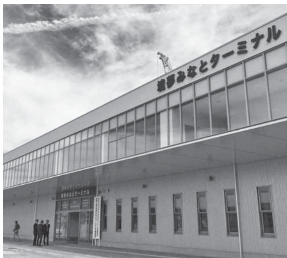
竹内南地区にぎわいづくりの核となる 境夢みなとターミナル
