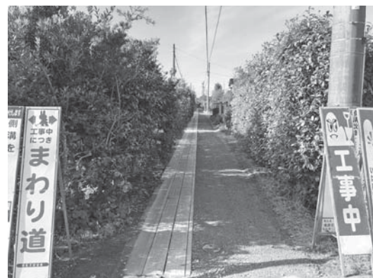
竹内町ですすむ市道・側溝の整備工事
