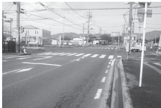
改良工事が予定されている渡公民館前交差点
