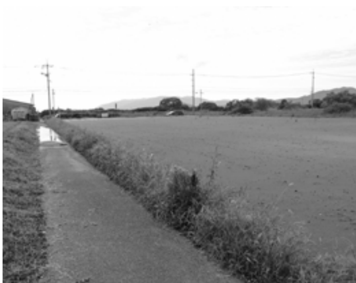
造成地と側道の水たまりの状況
