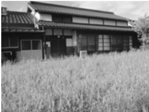
空家となった住宅
