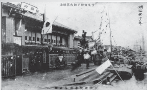
明治40年の境水道護岸の様子
