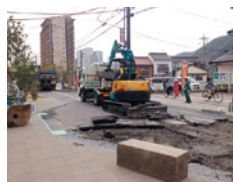
車道舗装(大正町)
