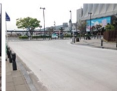
車道舗装(境港駅前)
