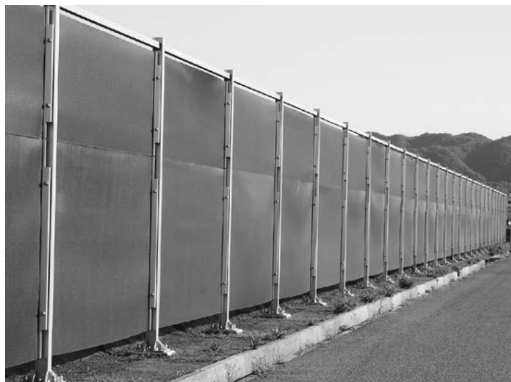
防砂ネット設置後の様子
