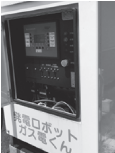
「旅籠屋」の非常用発電機
