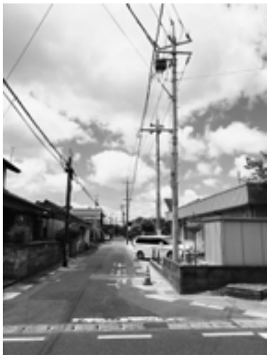
自治会館敷地内に移設した電柱（コーンの所が元の位置）
