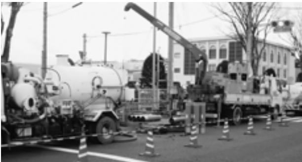
本年度も進められる下水道工事
