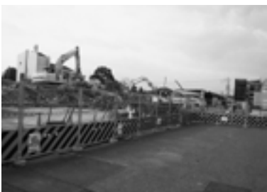
解体中の市民会館
