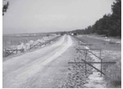
弓ヶ浜サイクリングロード（工事中）
