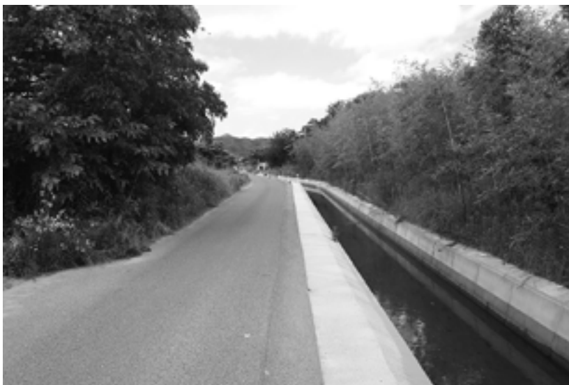
防犯灯のない農道
