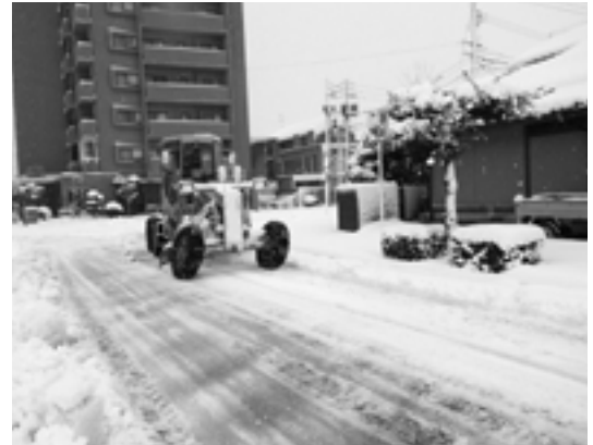
市内除雪作業状況
