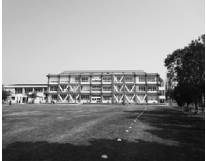
上道小校舎に設置された太陽光パネル
