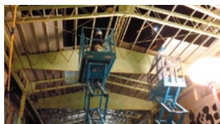
アーケード解体
