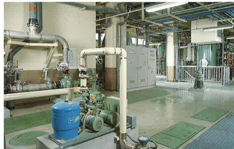
● 第一曝気槽・第二反応槽・汚泥分離槽・沈殿槽など
