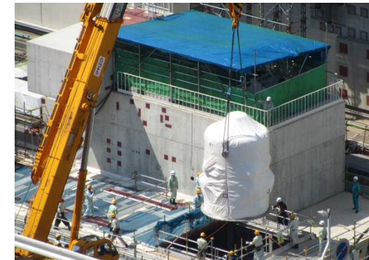
よう素フィルタ装置の吊り込みの様子 (平成27年4月)
