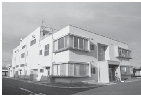
浄化センター（平成3年撮影）
