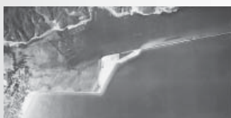
防波堤 (国土地理院撮影の空中写真 (S37 撮影))
