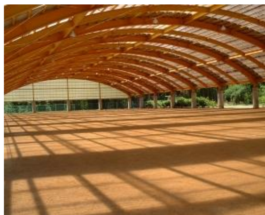
事例写真：大分県日田市の屋根付き広場
