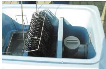
接触材を引き出し、付着した油等を取り除きます。汚れがひどい場合は洗剤で水洗いします。
