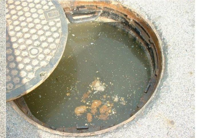
○下水道管の清掃後に終末処理場(佐斐神町)まで流れてきた油の塊130kgを手作業で回収
