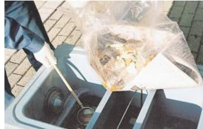
水面に浮いた油等はヒシヤク等ですくい出し、回収します。2、3槽目に浮いた油も同様に回収します。
