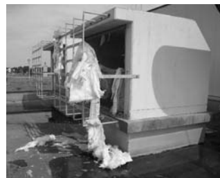
破損した防炎板 (被害額 687 千円)
