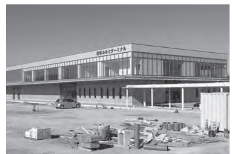
整備が進む「境夢みなとターミナル」
