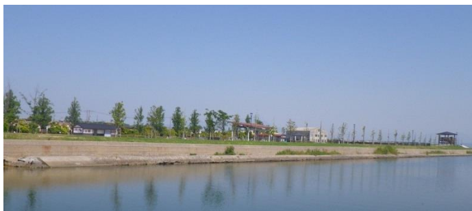
既設未整備護岸
