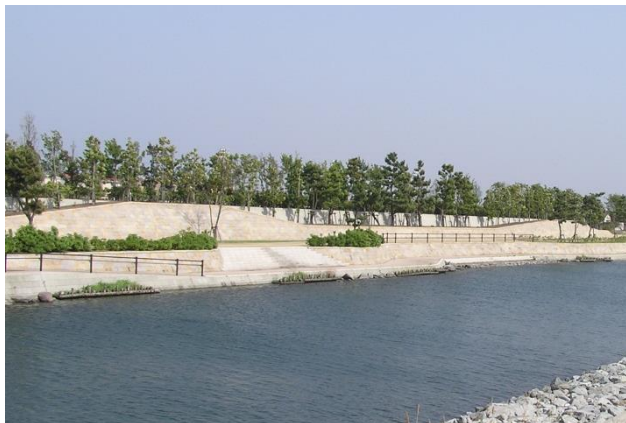
市民スポーツ広場付近
