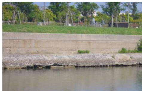
老朽化した既設護岸
