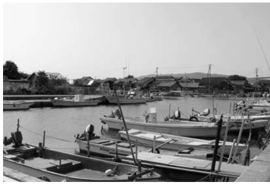
中海護岸整備事業の一環として整備される渡漁港
