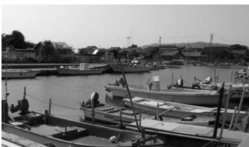
護岸整備について、協議が進められている渡漁港
